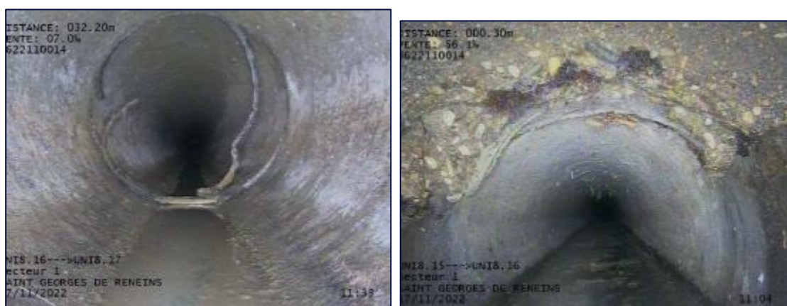
Figure 40 : Joints rompus (8.16-8.17) et présence de racines (8.15-8.16)
