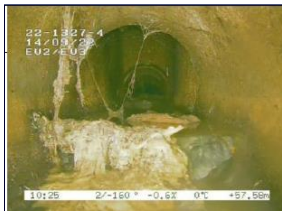
Figure 28 : Dépôt important entre EU2 et EU3
