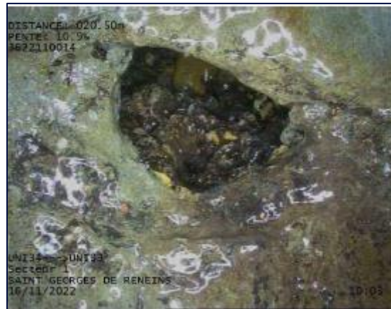
Figure 44 : Effondrement du collecteur tronçon 33-34
