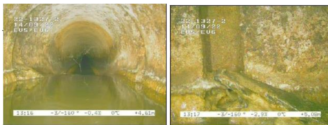
Figure 26 : Dépôt de matériaux entre EU5 et EU6
